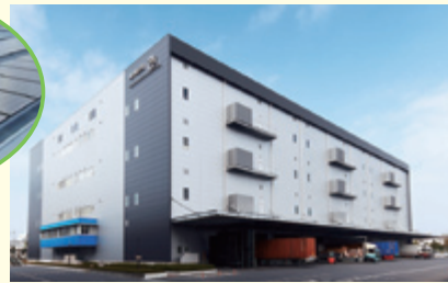
市川物流センタ外観
